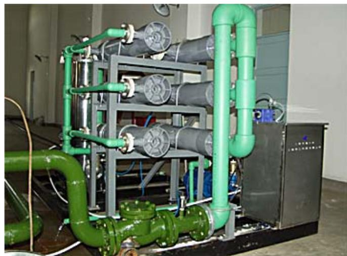
*Sistema de desoxigenación de calderas con contactores de membrana, construido por Shen Lan*
