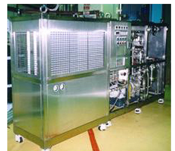
Contactores en uso en Wolsung NPP
